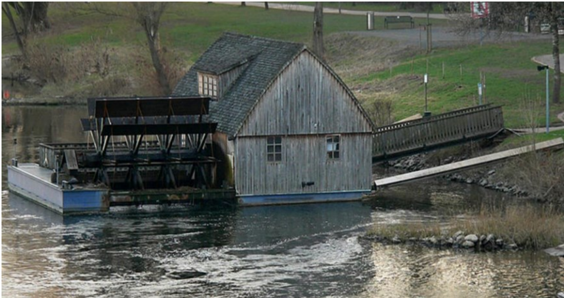
Bild 2: System einer Schiffsmühle
